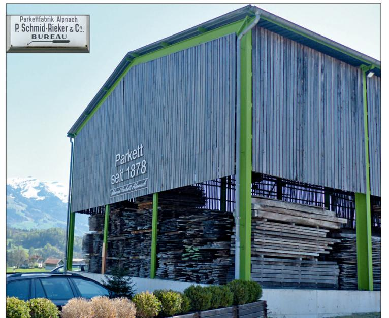
Im Holzlager trocknet das Holz auf 15 bis 25 % Restfeuchte, anschließend in der Trockenkammer auf 7 %. Auf eine 140-jährige Geschichte blickt Schmid zurück.
